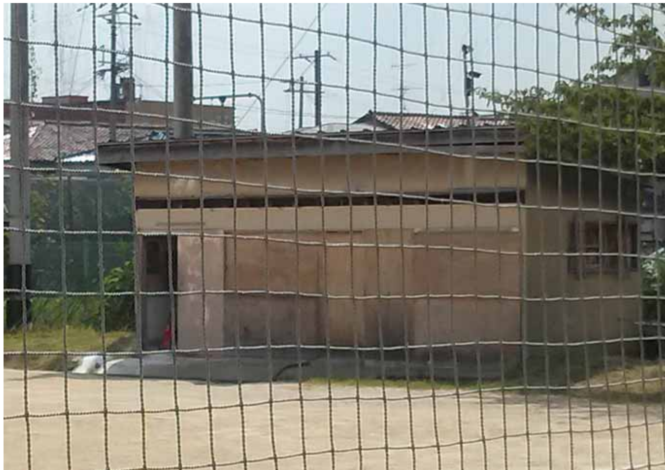
玉川中学校 不要な石灰倉庫
